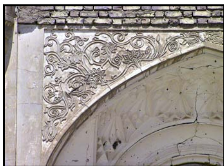
تصویر ۴. تزئینات گچی لچکی ورودی عمارت باغ فتح آباد.
