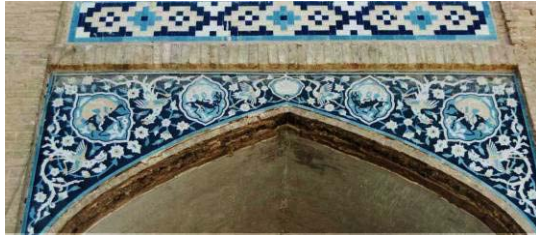
تصویر ۱۳. کاشیکاری معرق با نقش لک لک ها، سیمرغ و حیوانات. حیاط کاروانسرا. ضلع شرقی طبق پایین. ماخذ: نگارنده
