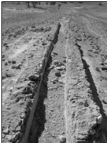
تصویر ۴. شبکه آبرسانی شهر که به صورت کانال‌های ساخته شده از سنگ و ساروج نمایان است. مأخذ: همان
