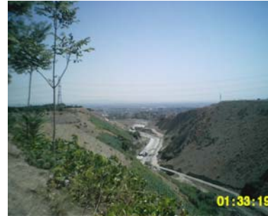
تصویر ۵-۱- دره فرحزاد در مجاورت ساختمان اداری
