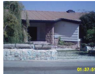
تصویر ۵-۲- نمایی از ساختمان اداری پارک پردیسان
