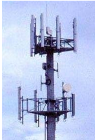
شکل ۱- آنتن ایستگاهی تلفن های همراه
