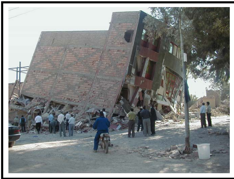
شکل ۲- ساختمان پنج طبقه نوساز در شهر بم که بر اثر زلزله تخریب شده است
