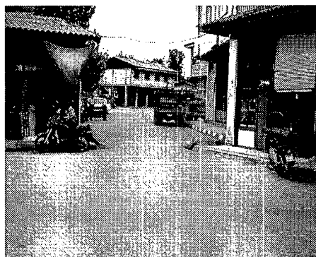
تصویر شماره ۷ اجرای ناقص تعریض معبر (جیرده، شفت)
