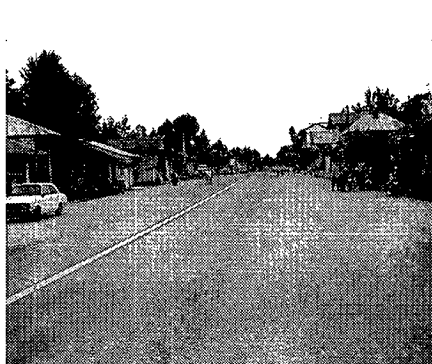
تصویر شماره ۶ یک نمونه از احداث معبر عریض (روستای رود پیش، فومن)
