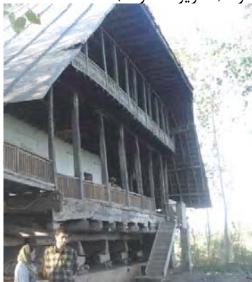
تصویر ۳- بنایی با پی شیکیلی در رودبند
