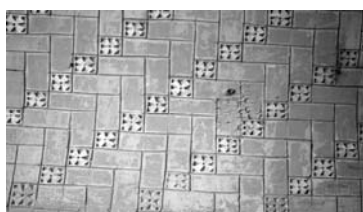
تصویر ۱ الف- نحوه قرار گیری توپیی ها در میان بند های آجر، (مقبره پیر بکران اصفهان).
