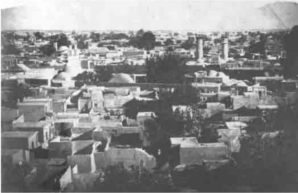
تصویر ۴- دید از شمس العماره به طرف شرق که ساختمان های با معماری سنتی (سقف صاف و گنبدی) را نشان می دهد. مأخذ: (سمسار، سرانیان، ۱۳۸۲)
