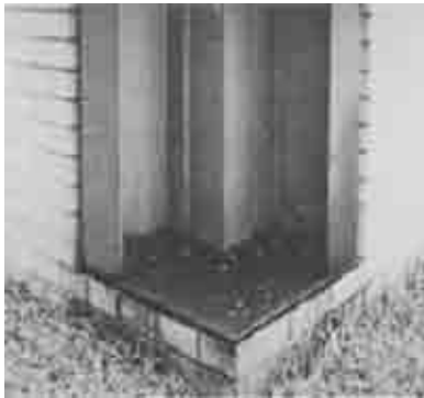
تصویر ۱۳- راه‌حل میس و ندروهه برای مسئله گوشه یک ساختمان، ساختمان سیگل، شیکاگو، ۱۹۴۷. ماخذ: (www.greatbuildings.com)
