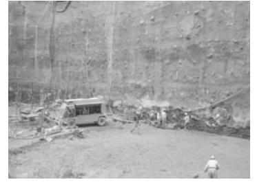
تصویر ۱۵- پایدارسازی جداره گودبرداری از خارج گود - روش میخ کوبی. (مأخذ: نگارنده)
