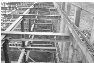
تصویر ۶- پایدار سازی جداره گودبرداری از داخل گود - روش تلفیقی (شمع در جا و مهار روبرو). (مأخذ: نگارنده)
