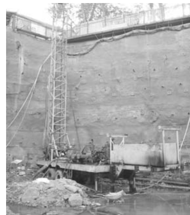
تصویر ۲۳- روش میخ کوبی - حفر چاه عمیق در بستر گود برای پمپاژ و زهکشی. (مأخذ: نگارنده)
