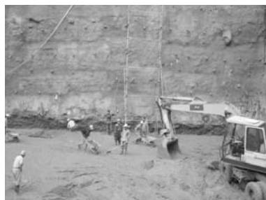
تصویر ۱۶- روش میخ کوبی - مشکلات اجرائی بالا بودن سطح آب زیر زمینی. (مأخذ: نگارنده)
