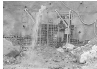
تصویر ۲۲- روش میخ کوبی - پمپاژ و زهکشی از چاه‌های دستی بستر گود. (مأخذ: نگارنده)
