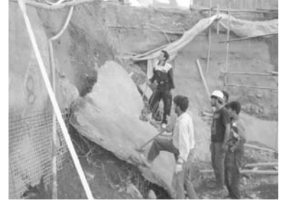
تصویر ۲۰- روش میخ کوبی - رانش پوسته بتنی قسمت آزاد بالای اولین ردیف میخ‌ها، (مأخذ: نگارنده)
