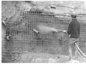
تصویر ۱۳- روش میخ کوبی - شاتکریت. (مأخذ: نگارنده)
