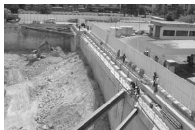
تصویر ۵- پایدار سازی جداره گودبرداری از داخل و خارج - روش تلفیقی (دیافراگم، مهار روبرو و انکراژ)، (مأخذ: نگارنده)
