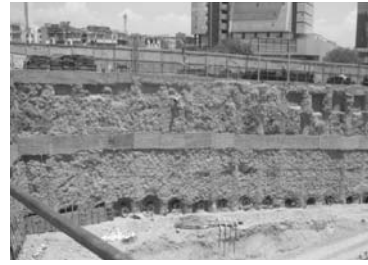
تصویر ۱۴- پایدارسازی جداره گودبرداری از خارج گود - روش تلفیقی (شمع افقی)، (مأخذ: نگارنده)
