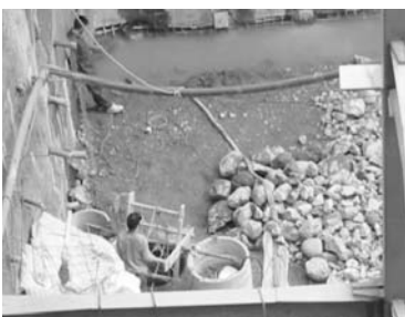
تصویر ۱۶- روش میخ کوبی - حفره چاه زهکشی در کف گود. (مأخذ: نگارنده)
