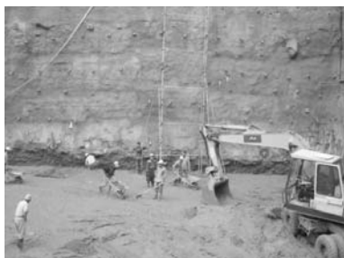
تصویر ۱۷- روش میخ کوبی - مشکلات اجرایی بالا بودن سطح آب زیر زمینی. (مأخذ: نگارنده)
