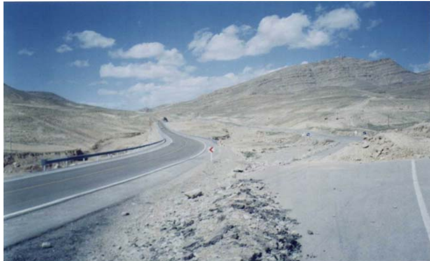
شکل ۱ احداث جاده بین‌المللی و جدید در کنار راه قدیم (مسیر قوچان- امامقلی)
