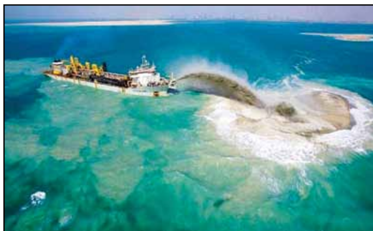
شکل ۴- آشفته‌گی در رسوبات بستر خلیج فارس در اثر استفاده از کشتی‌های لایروب به منظور برداشت مصالح مورد نیاز برای ساخت جزایر مصنوعی.
