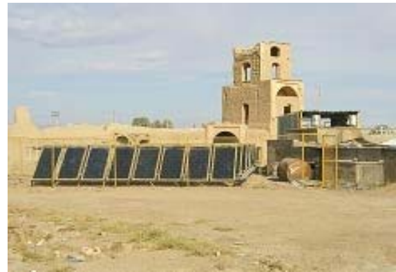
تصویر شماره (۴): نمایی از حمام خورشیدی نصب شده در
