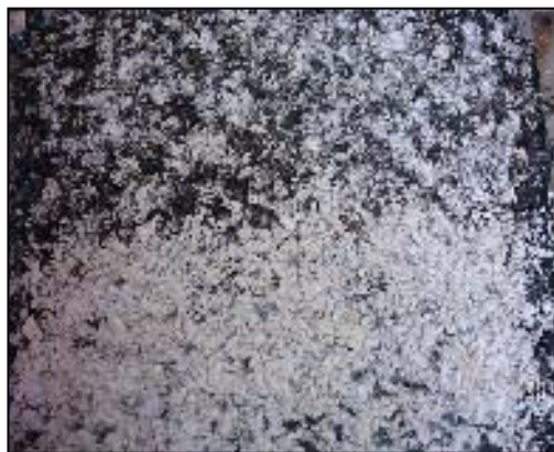
شکل ۴. بافت اندود سنگدانه‌ای گرانیت A
