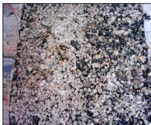
شکل ۵. بافت و مقطع اندود سنگدانه‌ای آهکی
