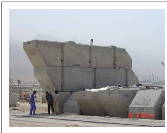
شکل ۲. تصویری از بلوکهای شیبدار در کارگاه ساخت قطعات پیش ساخته
