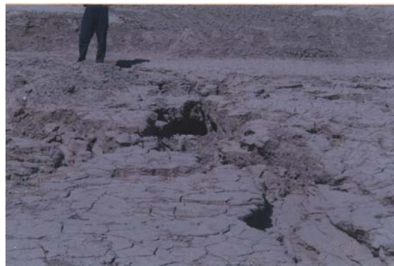
شکل 2. حفره ایجاد شده در منطقه شمس آباد میبد و گسیختگی‌های شعاعی در اطراف حفره
