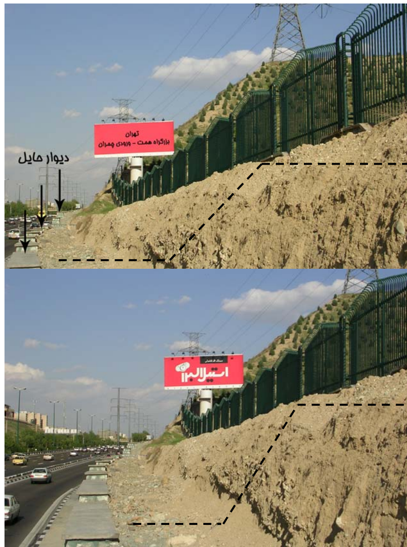
شکل 8- الف. دیوار حایل احداث شده در اتوبان همت، تهران
