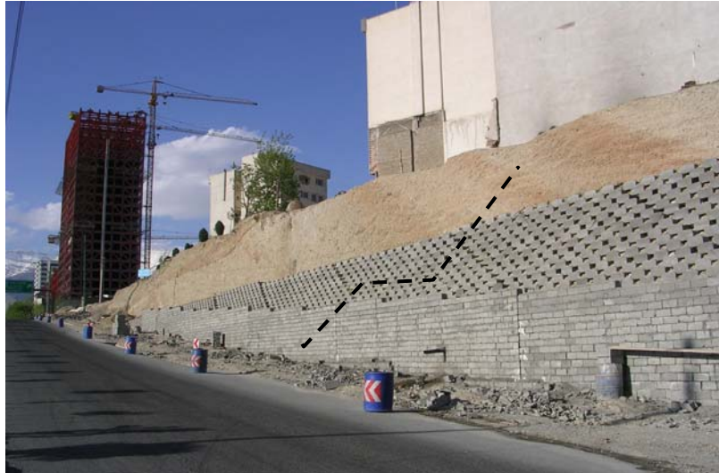
شکل 8- ب. دیوار حایل کنار خیابان برای پایدارسازی شیب و ایمن‌سازی ساختمانهای مسکونی بالای شیب
