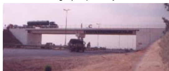
(ج) پل بتنی ماشین‌رو در اتوبان شهید معلم ورودی شهر اصفهان، تحریک شده توسط چکش ۲
