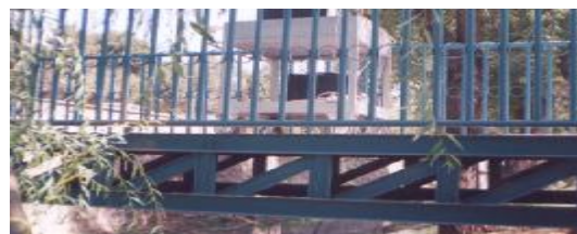
(ب) پل فلزی عابر پیاده در خیابان صائب در شهر اصفهان، تحریک شده توسط چکش ۲
