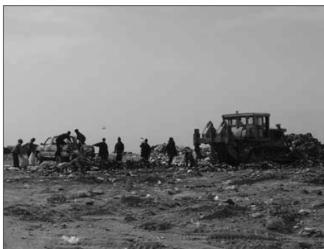
شکل (۳) : تلنبار پسماندها و عدم استفاده از خاک پوششی در محل دفن پسماند شهر پاکدشت
