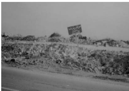
تصویر ۴ - عدم رعایت اصول صحیح دفع زایدات سنگبری و نخاله های ساختمانی در محل دفع تعیین شده
