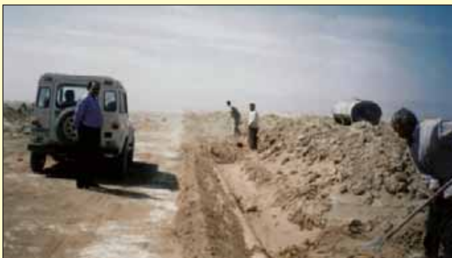
شکل ۲: خاک‌ریزی بر روی لوله‌های سفالی بعد از نصب لوله‌ها
