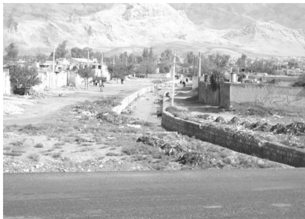
شکل ۷ کانالهای موجود در جنوب شهر به صورت کانال فاضلاب و تغییر کاربری داده و دارای شیب نامناسب می باشد.
