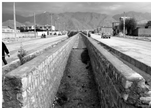
شکل ۸ کانالهای موجود شمال شهر دارای شیب مناسب
