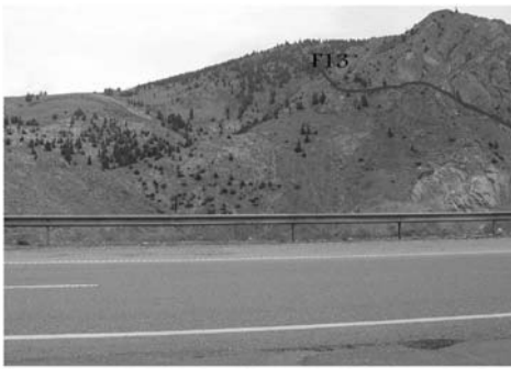
شکل ۵: کیلومتر ۵۲/۸۵ آزادراه، دید به سمت جنوب شرق، گسل F 13 در بالاترین پله ترانشه در توفهای آندزیتی
