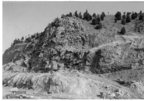
شکل ۴: کیلومتر ۵۰/۰۳ آزاد راه، دید به سمت شمال شرق، در آن خردی و شکستگی سنگها به وضوح مشخص است
