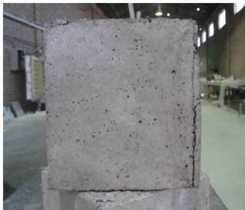
شکل ۵. حفره های ایجاد شده بر سطح بتن در اثر خروج بخار آب
