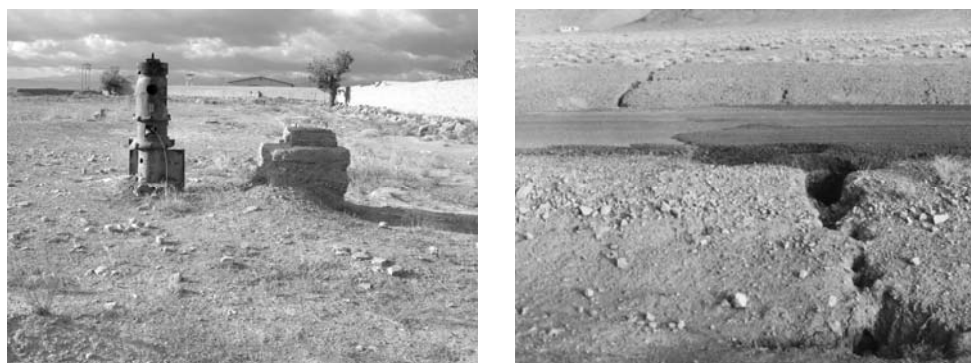
شکل ۱۰- لوله‌زایی و ایجاد شکاف در اثر نشست زمین در شمال‌غربی دشت مشهد شرکت آب منطقه‌ای خراسان رضوی (پائیز ۱۳۸۴).
