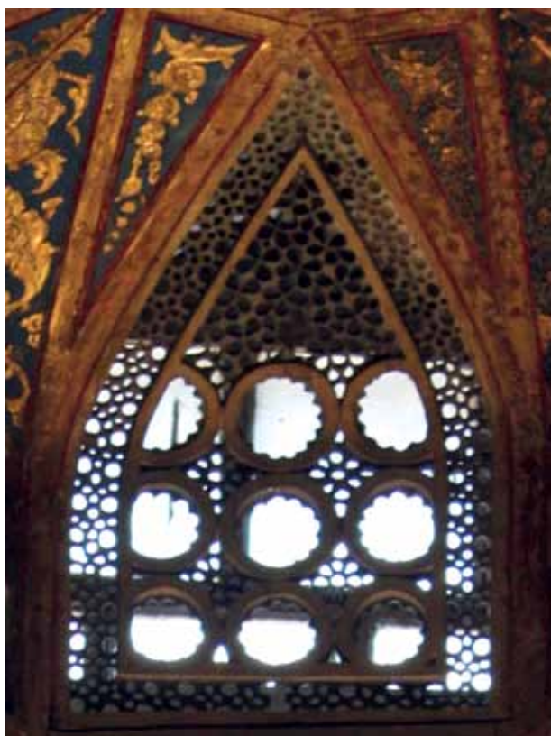
تصویر ۵. مشبک گچی بالای پنجره در کنه پوش جبهه شمالی، جنوبی، چینی خانه.
