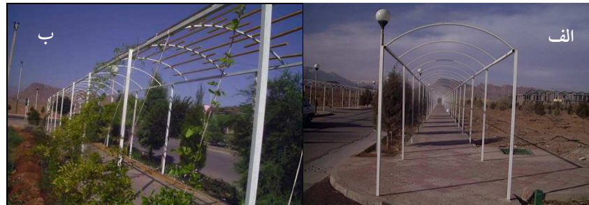
شکل ۱- الف- اسکلت اجرا شده در یکی از پیاده‌روی‌های پرتردد دانشگاه، ب- استفاده از چوب برای استقرار گونه‌های گیاهی بر روی سایبان.
