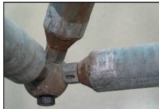
شکل ۱- اتصال چند عضو در شبکه دو لایه توسط سیستم اتصال گویسان
