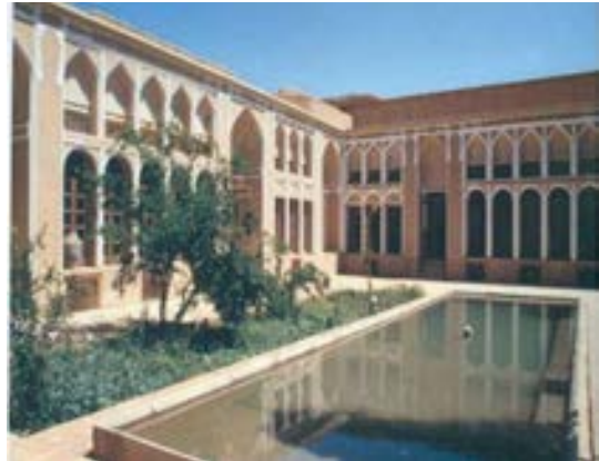
تصویر شماره ۳: جبهه شمال شرقی و شمال غربی خانه محمودی در مجموعه عرب‌ها، یزد
