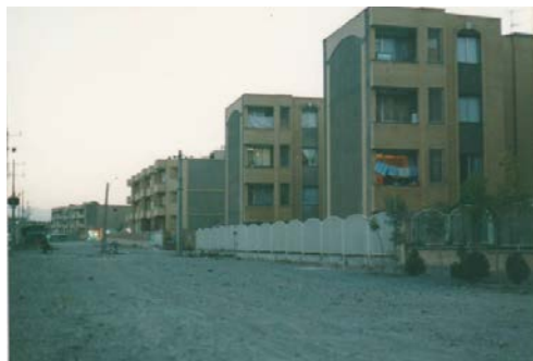
عکس ۷. آپارتمانهای امامیه
