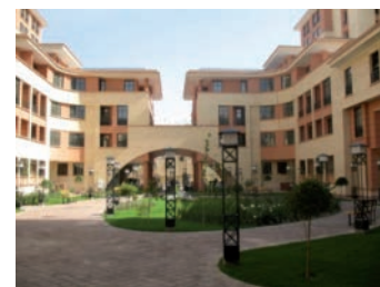
شکل ۲. بخشی از محوطه مجتمع زیتون
