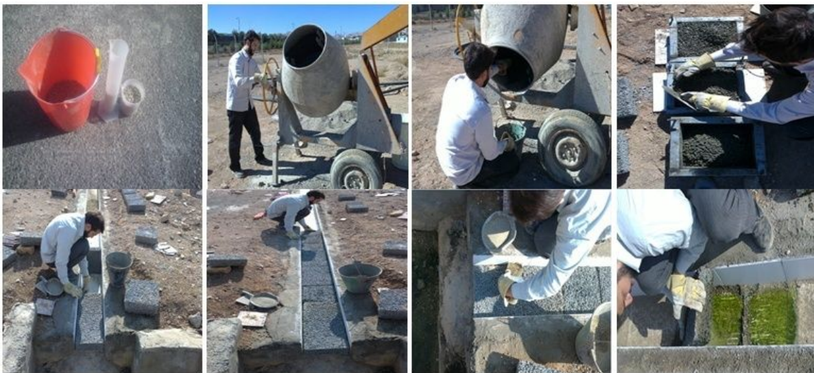
شکل ۴. مراحل تهیه بتن، قالب‌ریزی و قرارگیری بتن‌ها در کانال
