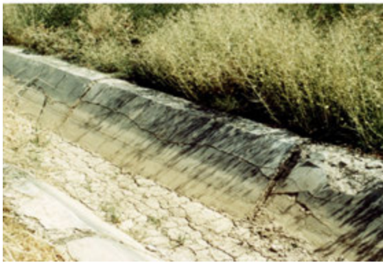
شکل ۱: وضعیت پوشش بتنی (سمت چپ) و سنگ وملات (سمت راست) در منطقه
