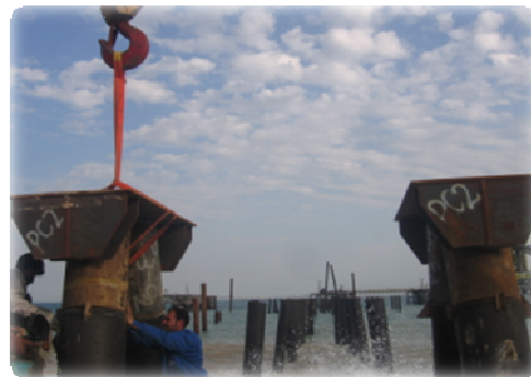
- نصب کپ پایل ها
