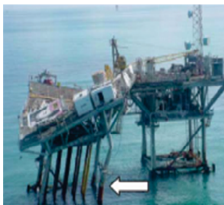
شکل ۱ خرابی سکو ناشی از نیروهای دینامیکی دریا
