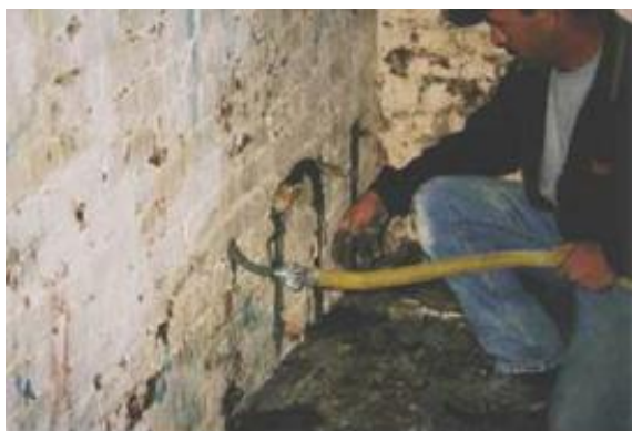
شکل (5): تزریق گروت در دیوار با مصالح بنایی
