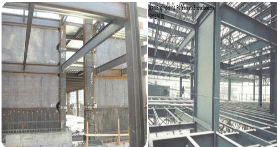
شکل 1: نمونه ای از دیوارهای برشی فولادی
