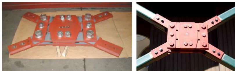
شکل (1): نمونه اجرا شده میراگر اولیه پال [4]
