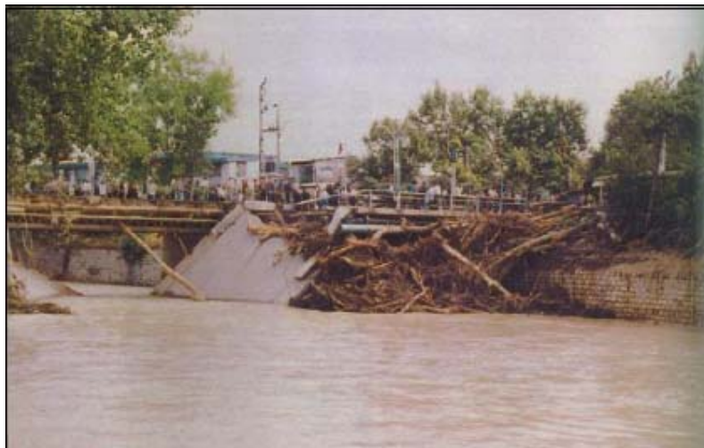
شکل شماره ۳- احداث سازه های تقاطعی نامناسب
