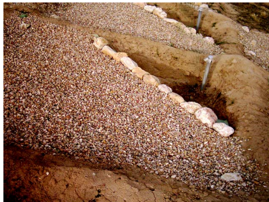
شکل (۴) نمایش سامانه سطوح آبیگر لوزی شکل
