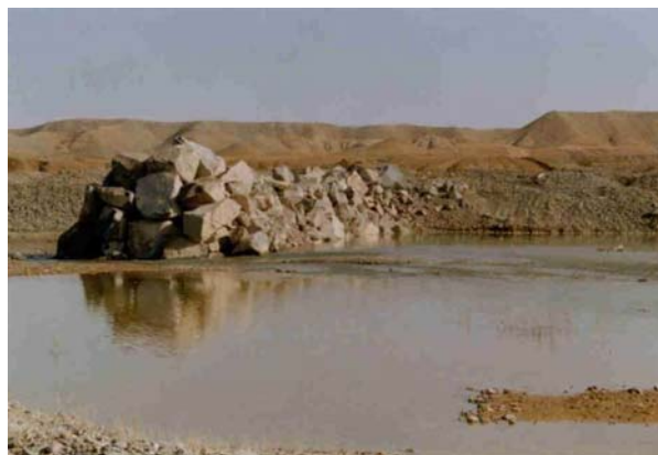
شکل (۲) عملیات سامان دهی رودخانه زنجانرود
