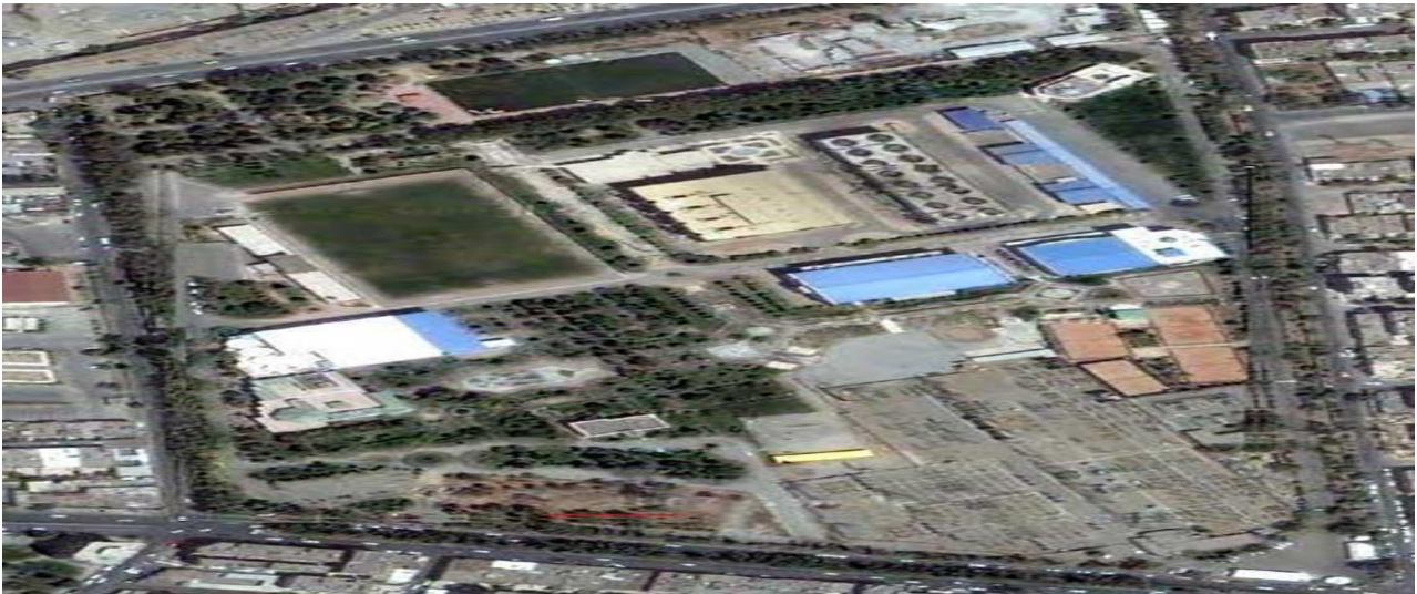
شکل ۱- نمای هوایی نیروگاه طرشت
