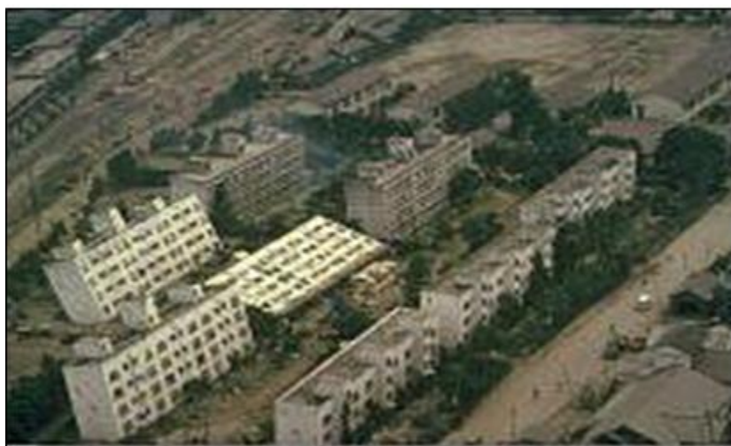
شکل ۱- روانگرایی رخ داده شده در زلزله نیگاتا ژاپن ۱۹۶۴
