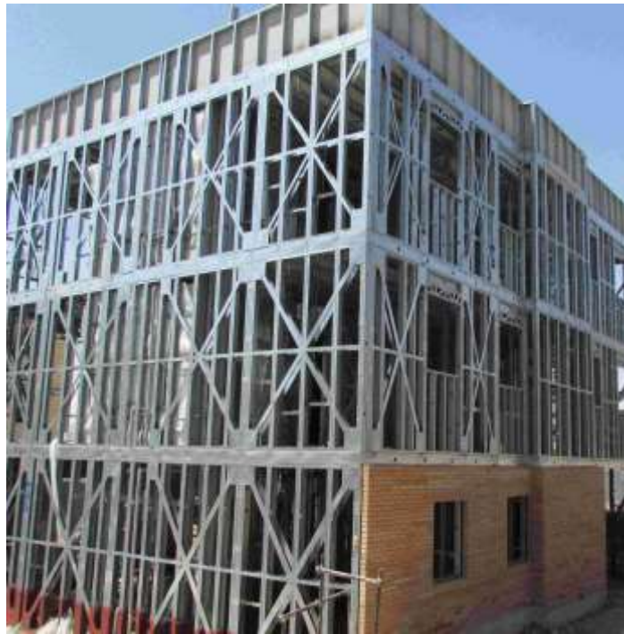
شکل ۱: ساختمان فولادی سرد نورد شده با مهاربند تسمه قطری
