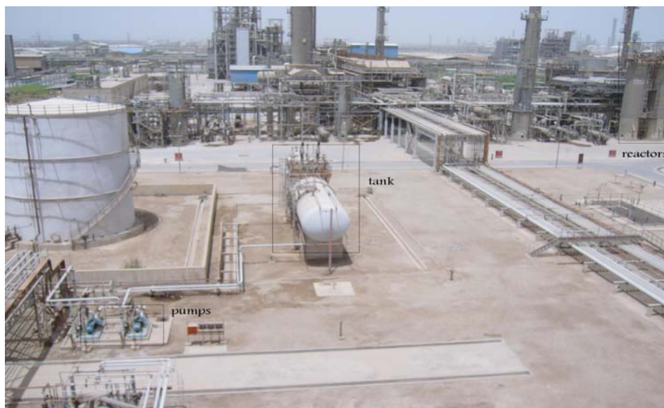
شکل ۳- نمایی از بخش سنتز MTBE و محل قرار گرفتن پمپ، تانک و راکتورها
