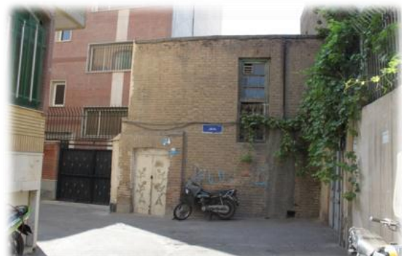
شکل 2- تقاطع کوچه حق پرست 1 با ملاباقر
