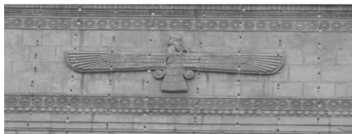
شکل 6 - استفاده از نقش فروهر در ساختمان بانک ملی ( ماخذ: همان).
