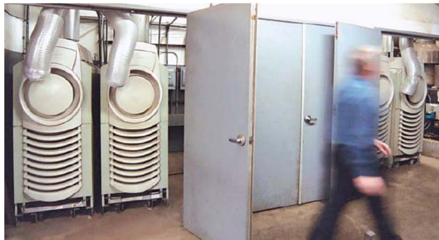
شکل (۱): واحد میکروتوربین کیستون C30 با توان ۳۰ کیلووات و مقایسه تقریبی با قد یک انسان
